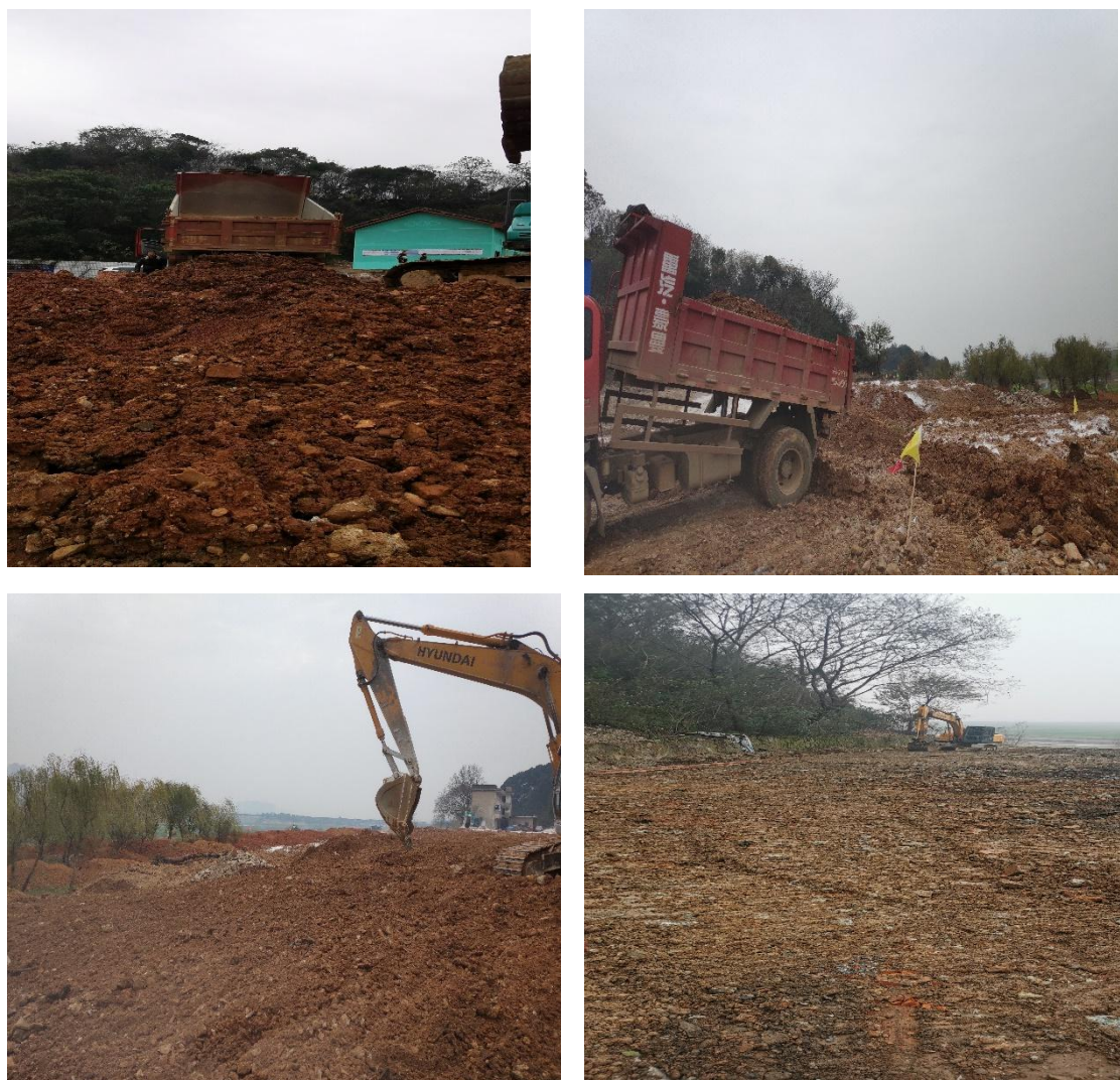
图 2.3.4-1 固化达标土壤回填平整记录
