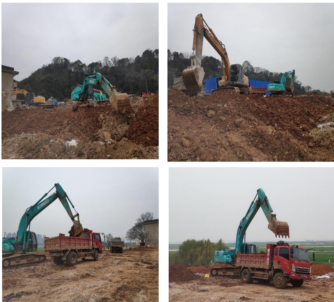
图 2.3.2-2 污染土壤清挖转运过程记录
