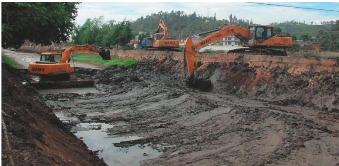
图 2.3-3 挖掘机底泥清理示意图
