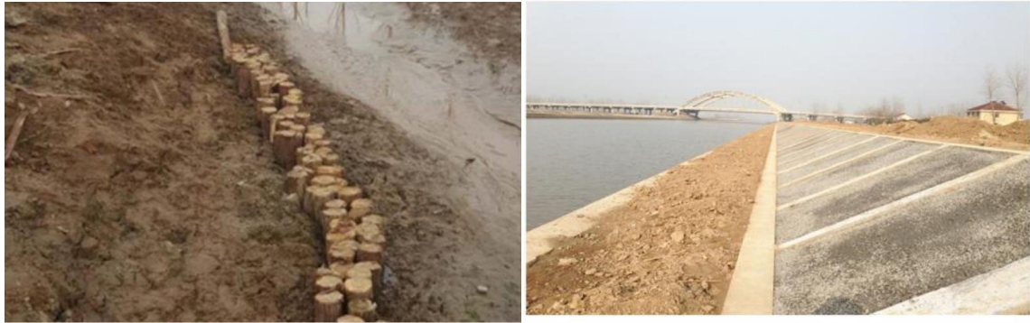
图 2.3-8 松木桩护脚和浆砌石护脚
